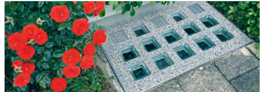
^ Lichtschachtabdeckung aus Glasstahlbeton
